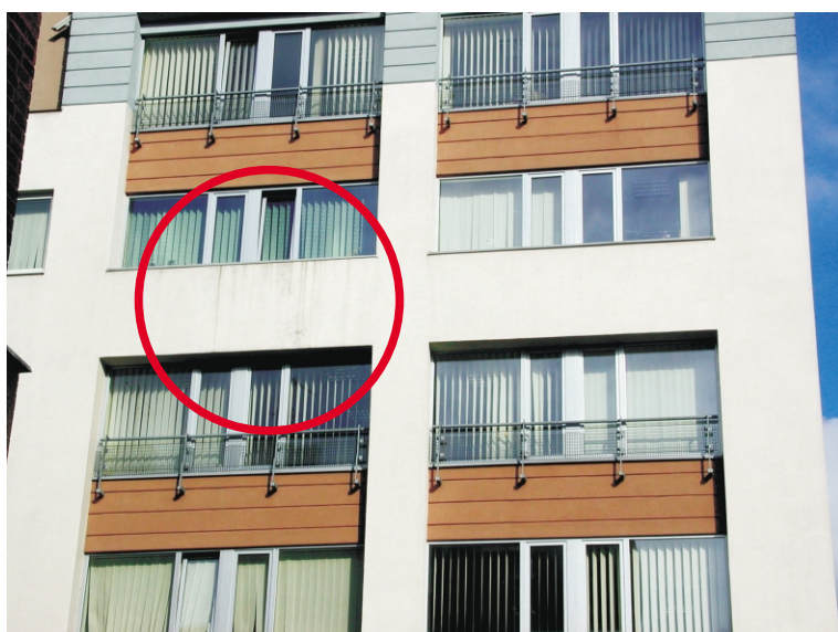
Zdjęcie Nr 1. Przykład źle osadzonej stolarki okiennej. Zbyt małe odsunięcie okapnika od płaszczyzny elewacji powoduje brudny zaciek poniżej. Usterka taka może być zauważona na elewacji w ciągu kilku tygodni po wykonaniu elewacji i szybko usunięta w ramach rękojmi przez wykonawcę elewacji
